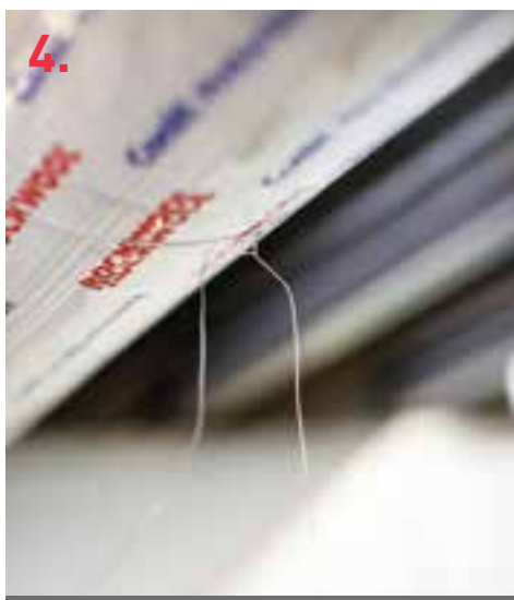
Rørskålen omvikles med vindseltråd ved enderne og midt på rørskålen.
